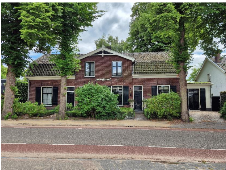
Foto 4 'Rustoord' aan de Traaij 92-94. (S. Wegereef)
