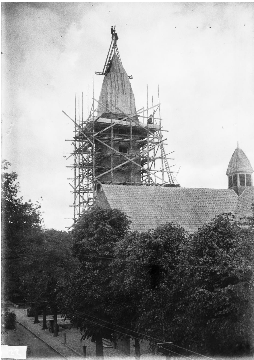
Foto 9 De toren van de hervormde kerk in Driebergen in aanbouw omstreeks 1926. (Collectie RAZU)
